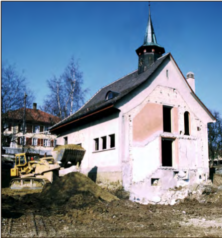
Bauarbeiten für den Erweiterungsbau
