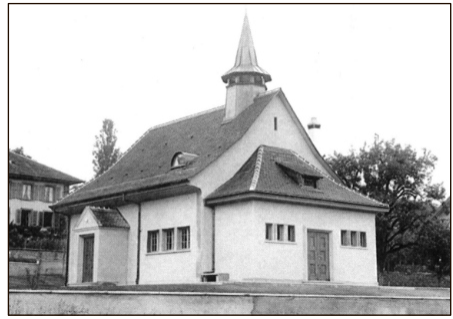
Das Kirchgemeindehaus Oberbottigen, erbaut 1933/34 Foto: Sammlung Peter Schär
